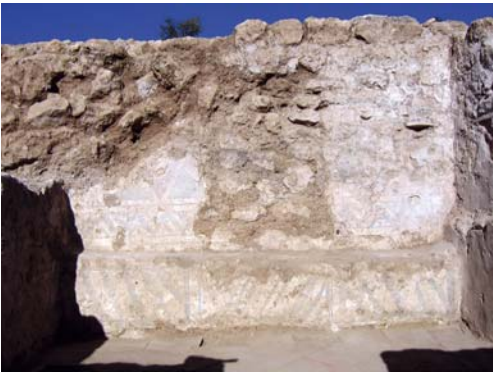
<< Abb. 5: Villa, Raum 3, Nordmauer
