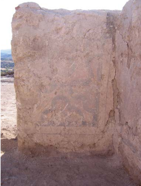
Abb. 12: Villa, Raum 3, Südmauer
